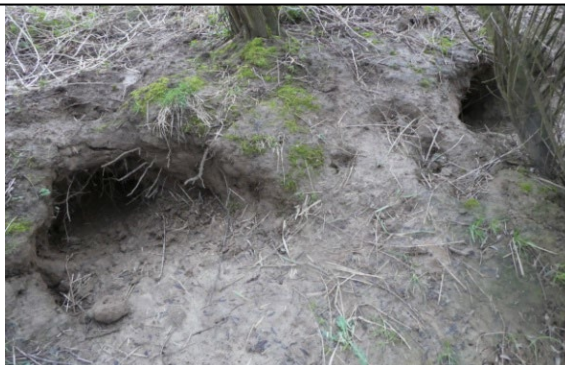
Terrier de blaireaux dans les berges du Ry des Ryes
