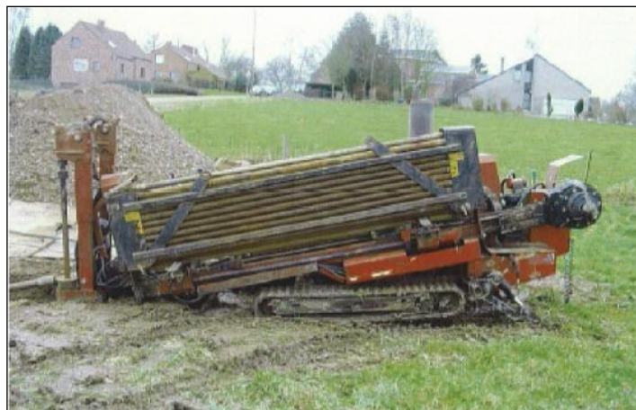
Figure 22 : Foreuse (source : Decube Consult, 2003).
