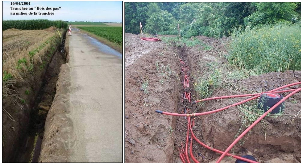
Figure 17 : Travaux de pose de câbles de raccordement (source : Luminus, parc éolien de Villers-le-Bouillet et de Héron, 2004 et 2016).
