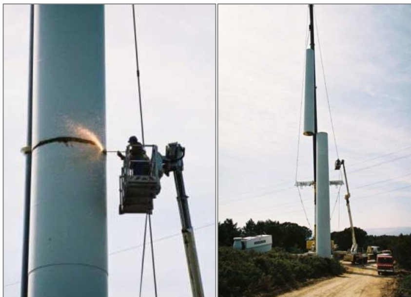
Figure 27 : Découpage et démontage d'une éolienne (Sallèles-Limousis (France), 2010).
