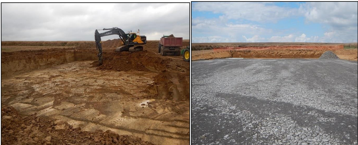
Figure 18 : Aire de montage au pied d'une éolienne (source : Luminus, parc éolien de Héron, 2016).
