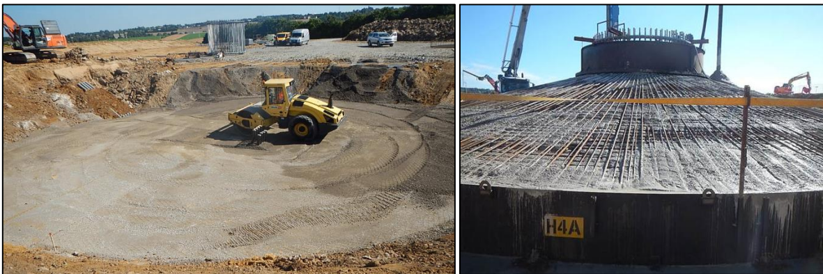
Figure 19 : Différents stades d'exécution d'une fondation circulaire (source : Luminus, parc éolien de Héron, 2016).
