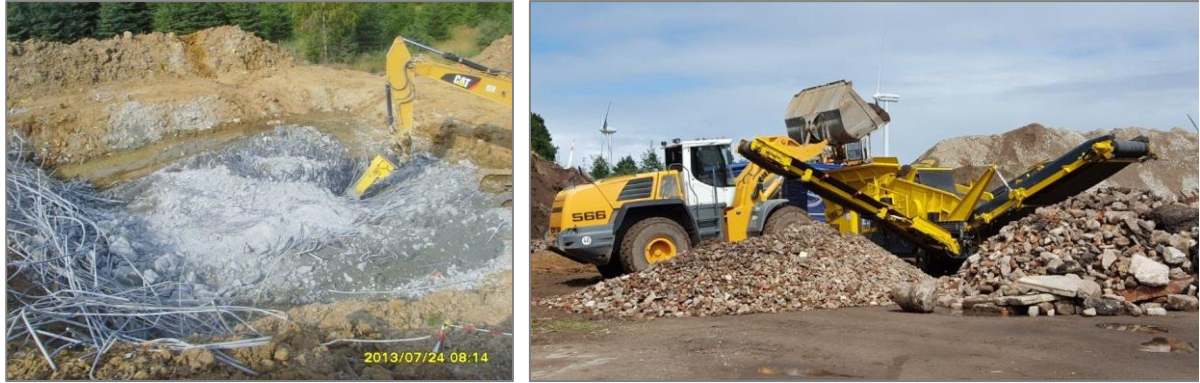
Figure 26 : Démantèlement de la fondation d'une éolienne – séparation des fers et concassage du béton (Schmees Bau GmbH, 2013).
