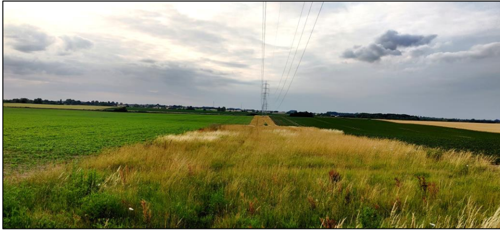
Figure 59 : Bande enherbée sous la ligne à haute tension.
